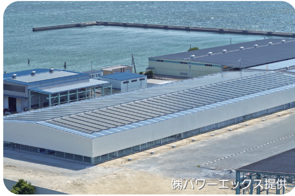
パワーエックス社の工場
