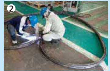
鉄パイプをハート型に曲げ加工
