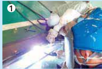
鉄パイプの溶接
