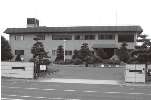
岡山県児島湖流域下水道浄化センター (東七区 453)
