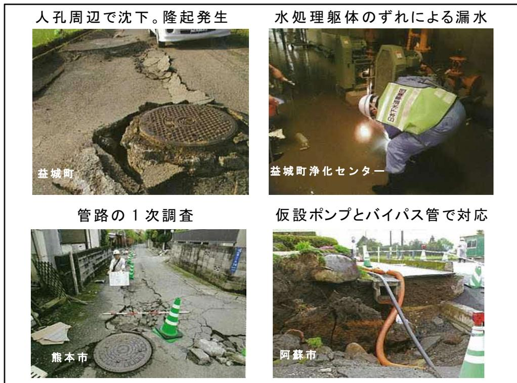
写真 大地震による下水道施設の被害 (熊本地震H28.4)
