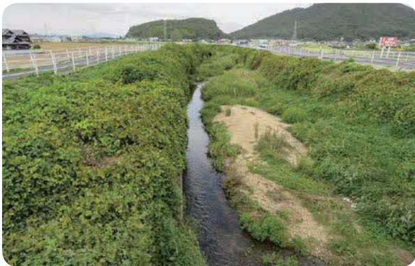
護岸改修が予定されている鴨川
