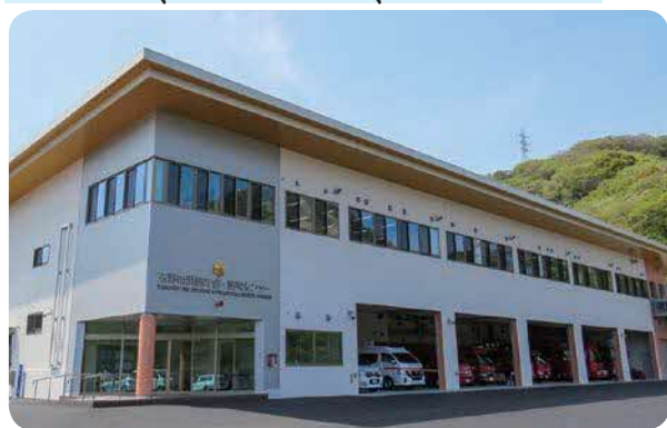
令和3年4月開設の新消防庁舎・防災センター
