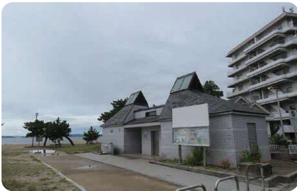
渋川海岸周辺に設置されている公衆トイレ
