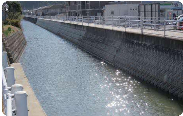
護岸整備された庄田川の様子
