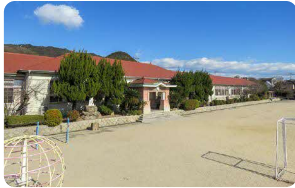
耐震工事がされていない鉾立小学校
