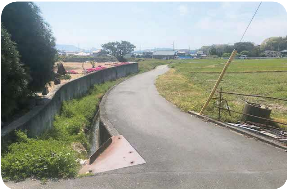
転落防止柵がない市内の用水路
