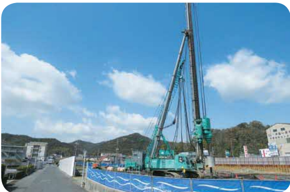
新病院建設工事の様子
