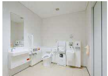
多目的トイレの例（北見市庁舎）
