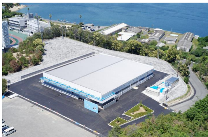
新学校給食センター R4.6.30 竣工
