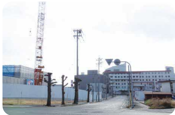
建設中の新病院(左)と現在の市民病院(右)
