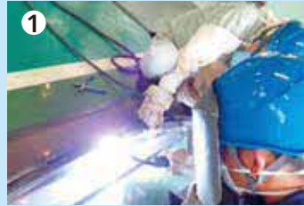
鉄パイプの溶接
