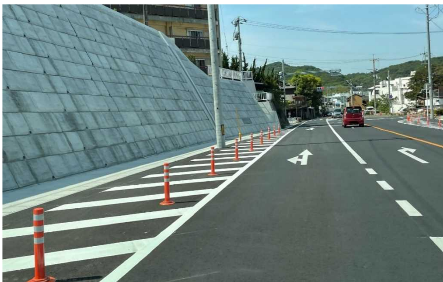
玉第一隧道交差点付近
