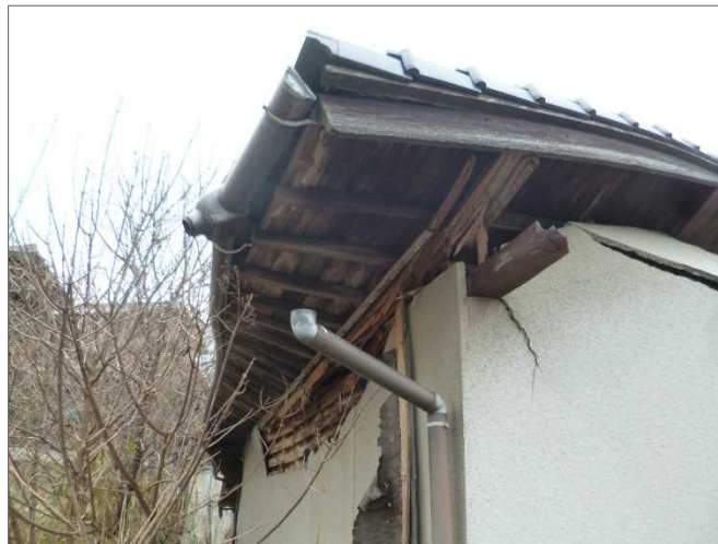
建築物の外壁や屋根の腐朽・破損・欠落の例
