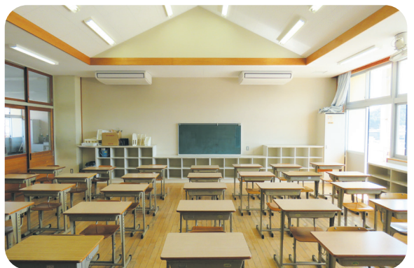
エアコン設置済の教室
