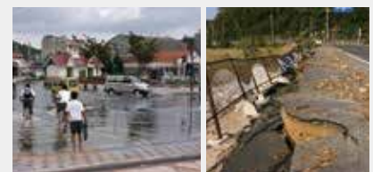
▲平成16年8月~10月 高潮・豪雨災害被害
