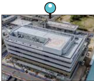
R8.5 外構工事
