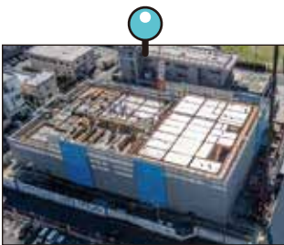
R7.10～R8.4 3～5階躯体工事
