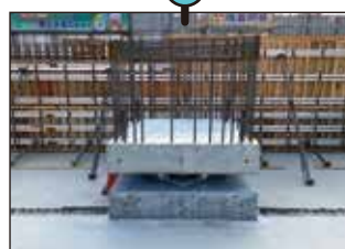
R7.5～6 免震装置据え付け
