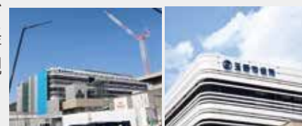
建設工事の様子(3月) 新庁舎南側の切文字看板
