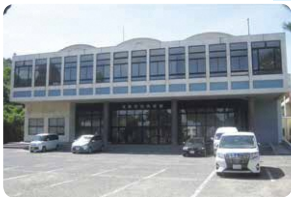
老朽化の進む市民会館
