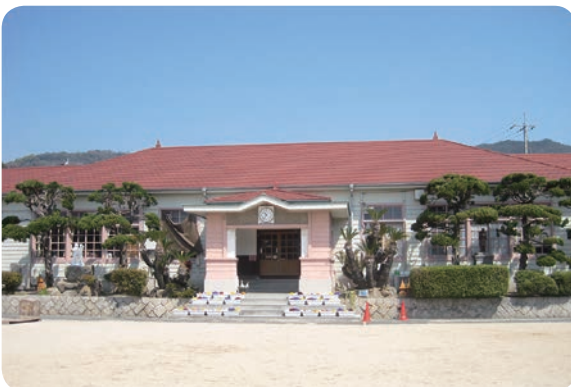
本市唯一の木造校舎(銚立小学校)
