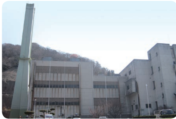
老朽化している東清掃センター
