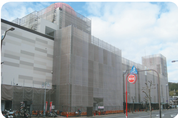
リニューアル工事中のメルカ
