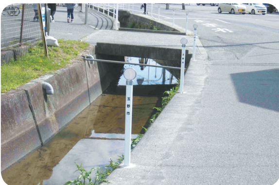
転落防止のポール
