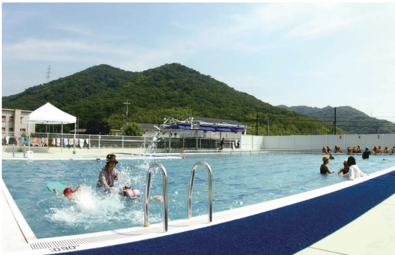
新設された小学校プール（八浜小学校）
