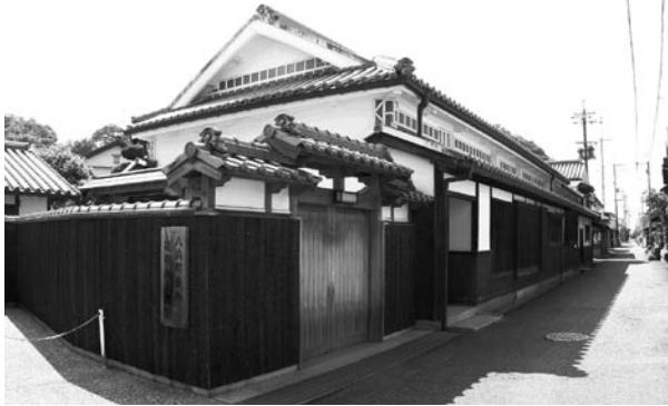
八浜街並み保存拠点施設
