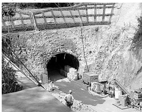
平成 21 年度末に完成予定の玉野トンネル
