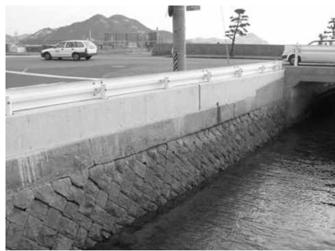
護岸のかさ上げによる高潮対策（藤井地区）
