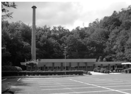
斎場の早期整備が期待されている
