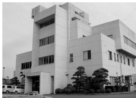
浄化センター
