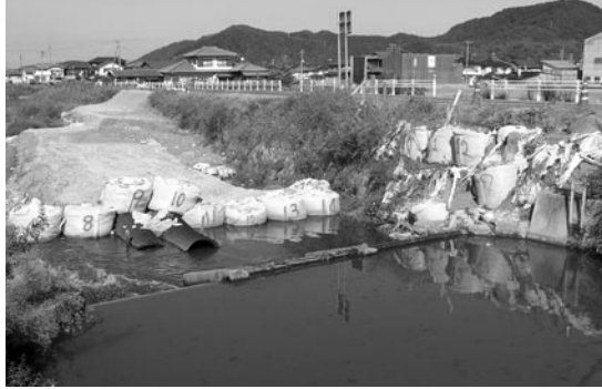
加茂川の災害復旧工事
