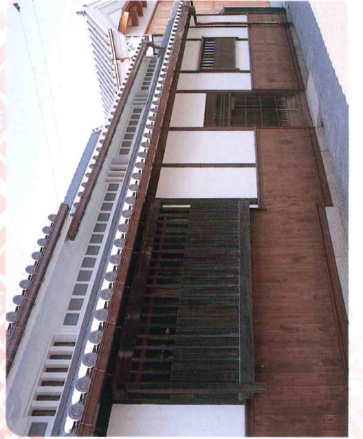
木造つし二階・本瓦葺 外観はしつくい塗り・なまこ壁・板張り ※つし二階
