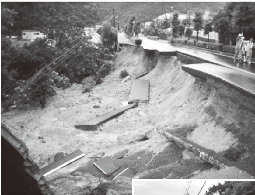
【上】路肩が崩壊した国道430号 (日比6丁目)
