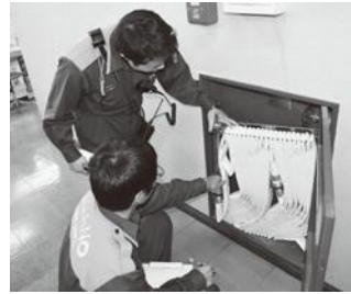
▲消火ホースなど施設の設備点検
