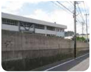
第二比小学校 コンクリートブロック塀
