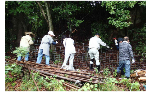
地域住民による防護柵設置の様子
